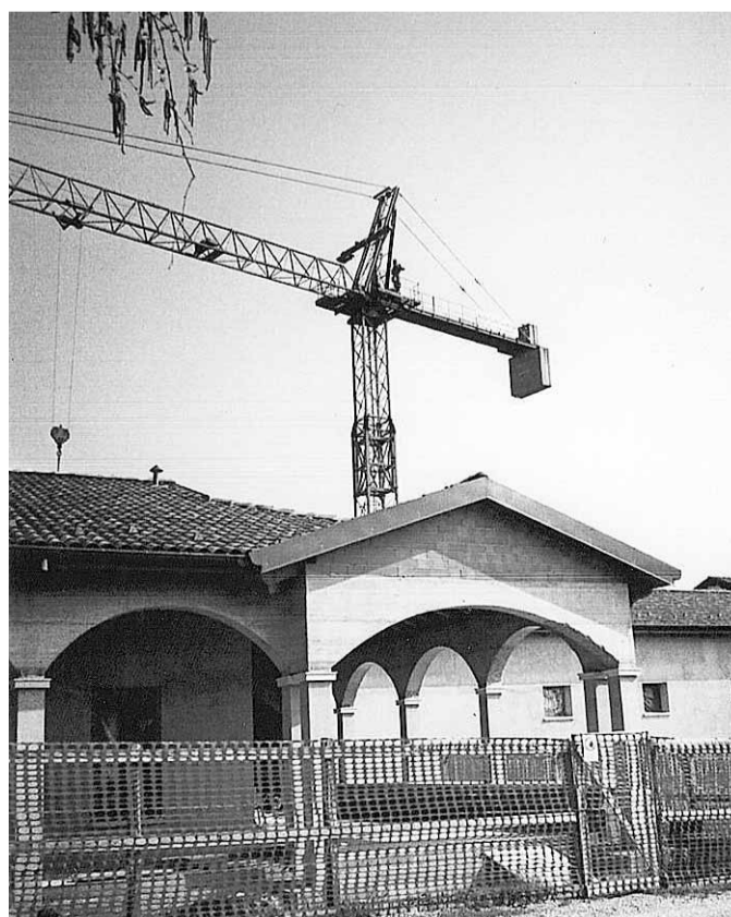
Lavori in corso ad Anima Universale
